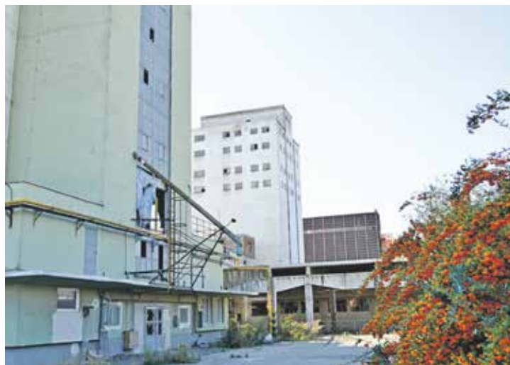
Demolice síla soukromé společnosti a sanace areálu proběhnou společně, aby co nejméně zatěžovaly okolí. Foto | město Vyškov
