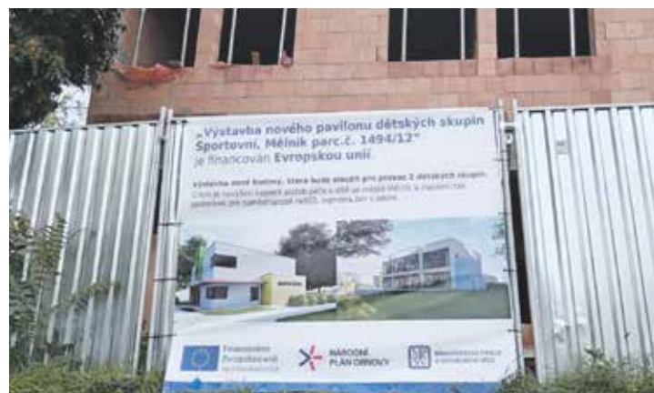
Stavba objektu dětské skupiny je oproti jiným složitější ve splnění všech hygienických, energetických a bezpečnostních norem. Stavební práce zatím probíhají podle plánu. Foto | město Mělník
