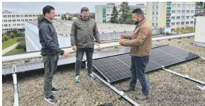
Zástupci města a městské společnosti na střeše 6. ZŠ při instalaci fotovoltaických panelů.
