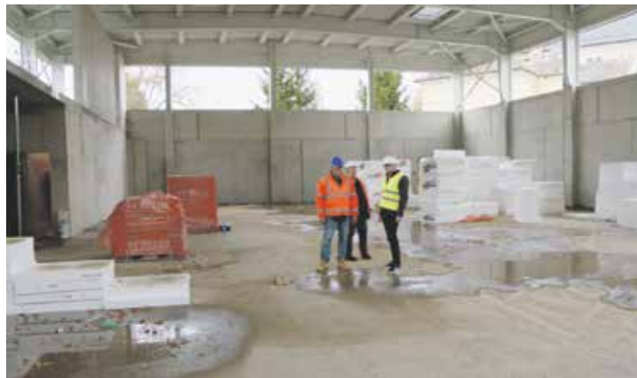
Stavební práce na nových budovách čakovické školy postupují podle plánu. Foto | MČ Čakovice
