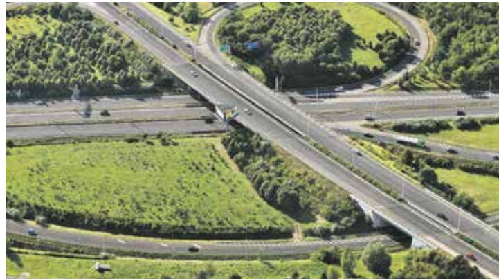
Výstavbu nové čistírny odpadních vod ve Vinoři sladí s plánovanou trasou Pražského okruhu. Foto | Ministerstvo dopravy
