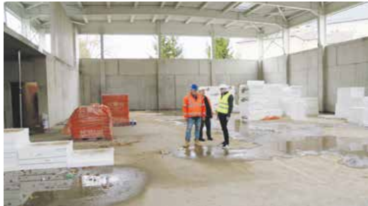
Stavební práce na nových budovách čakovické školy postupují podle plánu. Foto | MČ Čakovice
