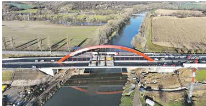
Během zkoušky se měří prohnutí, posuny a napětí v konstrukci. Foto | město Napajedla
